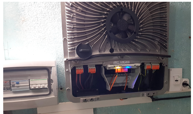
/ La tecnología de ventilación activa de los inversores Fronius aumenta la vida útil y el rendimiento del sistema FV
