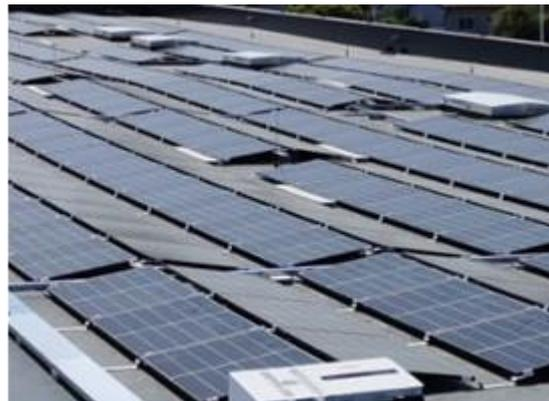
Abbildung 2: PV-Module in Ost-West-Ausrichtung
